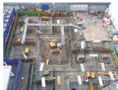
上空からの仮設棟建設工事現場(5月撮影)
