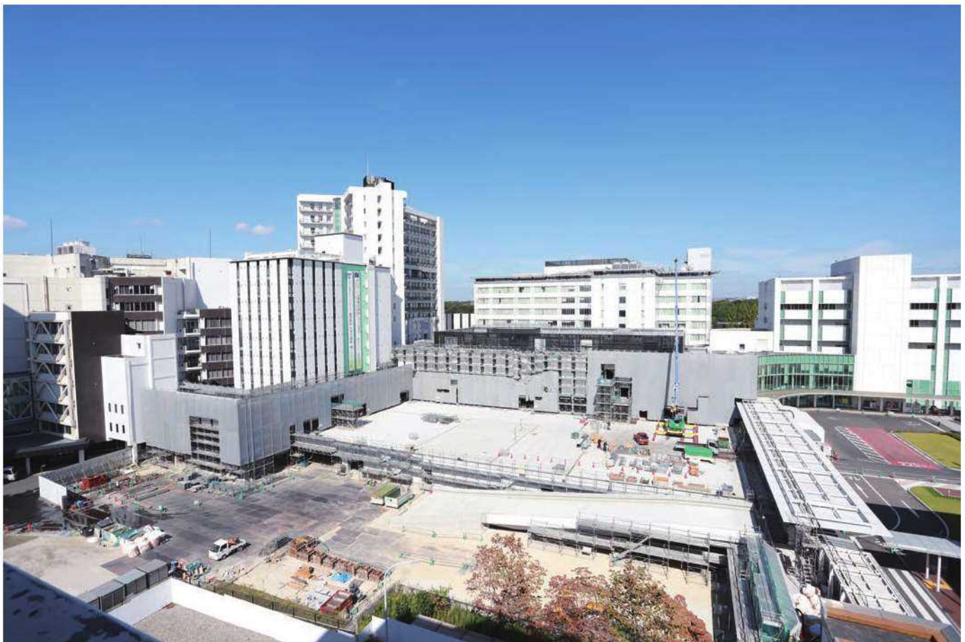
利便施設棟建設工事風景
