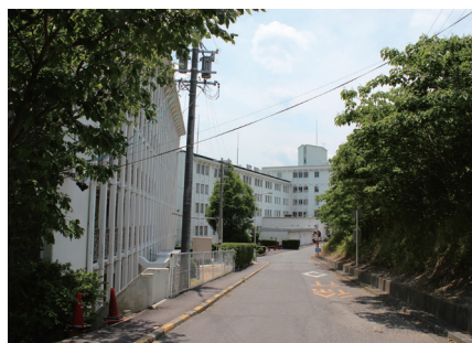
写真2a(手前建物1,2階)
